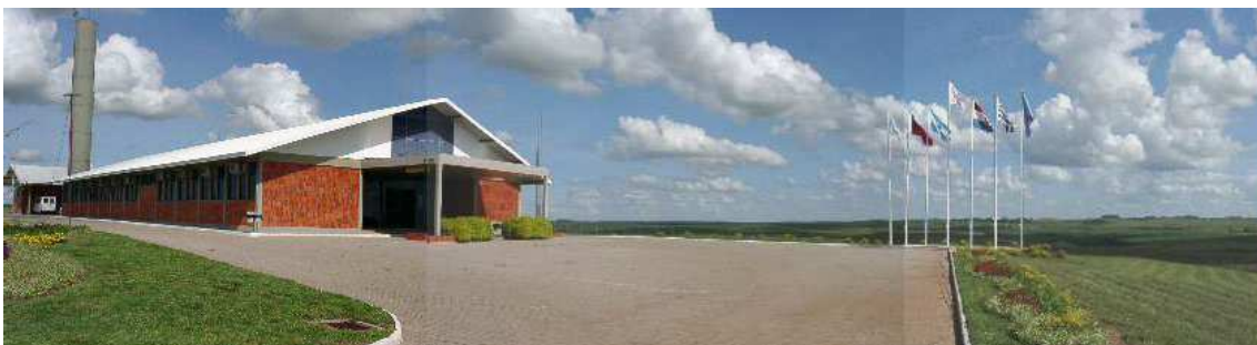
FIGURA 2.4: Foto do prédio principal OES, onde está instalado o TCM, em São Martinho da Serra.
